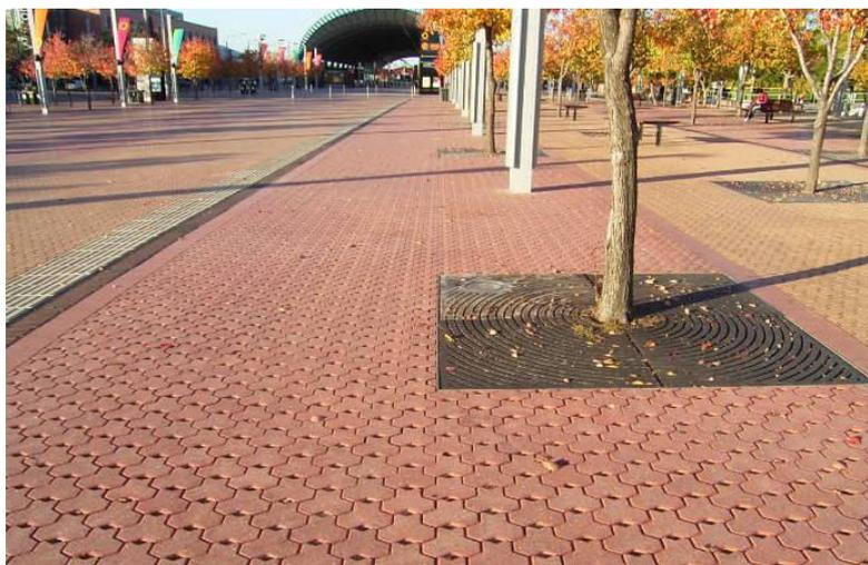
**Figura 13: Pavimentazione drenante.**
