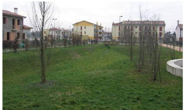
**Figura 9 – Bacini di infiltrazione.**
